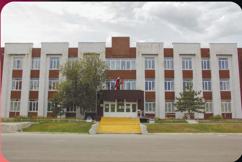
Замена оконных блоков в школе искусств
