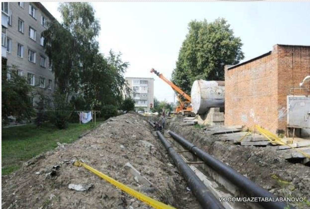
ул. Лесная - прокладка сетей к блочно – модульной котельной
