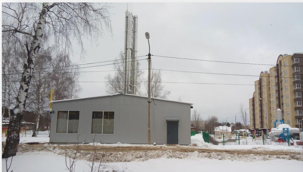
Блочно - модульная котельная на ул. Южная
